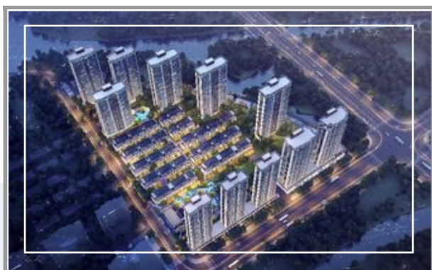
▷ 温岭市XQ070120地块（玖珑和玺）建设 项目
