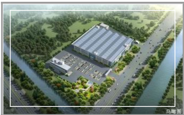
▷ 浙江乐骑机车有限公司新厂区项目
