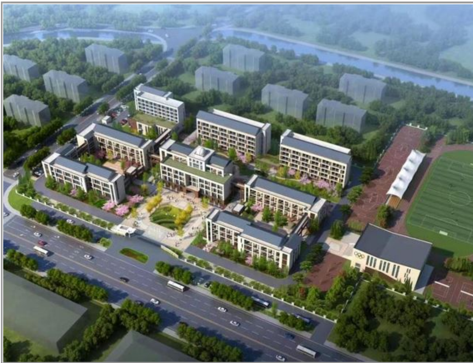
☆温岭市城南中学迁建工程（2020年度浙江省建设工程“钱江杯”）
