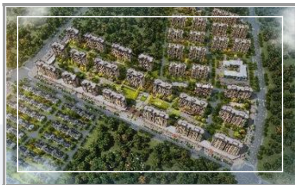
▷ 衢江区廿里镇彭家村棚改安置小区建设项目
