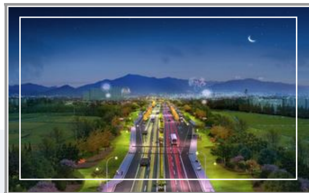
▷ 富阳区大桥南路提升改造工程
