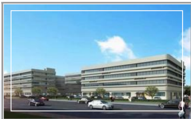
▷ 温岭市泽国镇 ZG160201-1 地块（光明老工业点改造）工程
