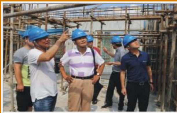
■ 公司骨干赴上海考察装配式建筑
