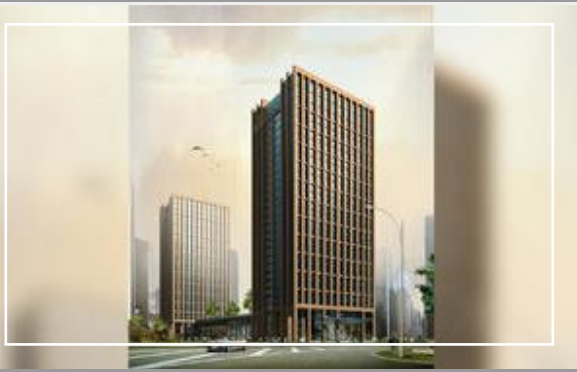
▷ 温岭市总部经济大厦工程 BT 项目
