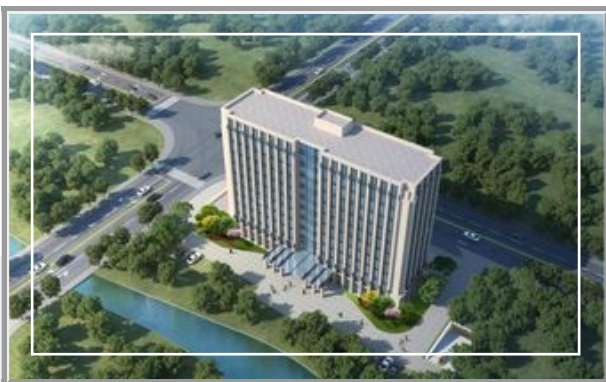
▷ 河姆渡镇车厰大桥北接线东侧、派出所西侧地块商业用房项目
