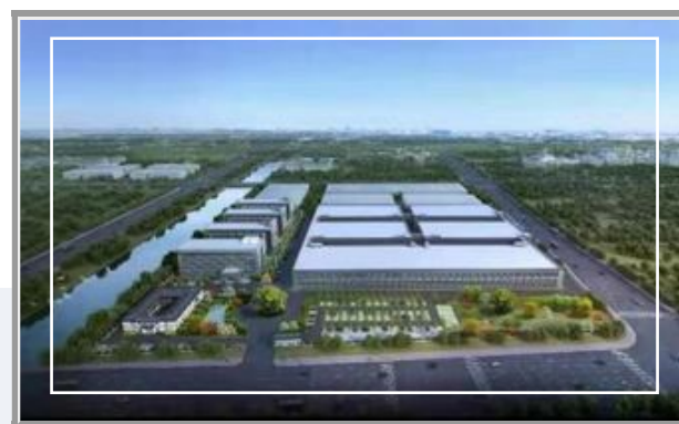
▷ 川能智能科技（台州）有限公司厂房建设项目
