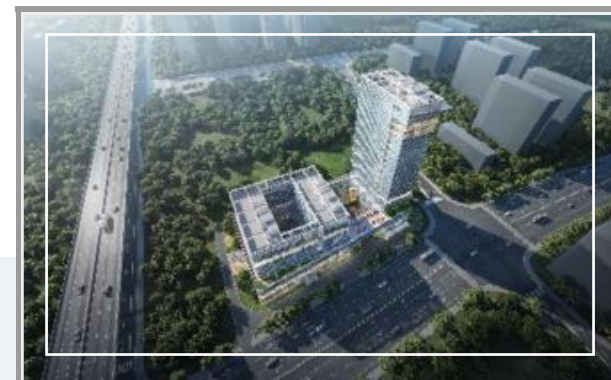
▷ 杭政工出【2021】56号地块工业用房工程
