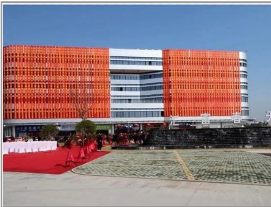
☆汇富春天电子商务园工程 (2019年度台州市标化工地)
