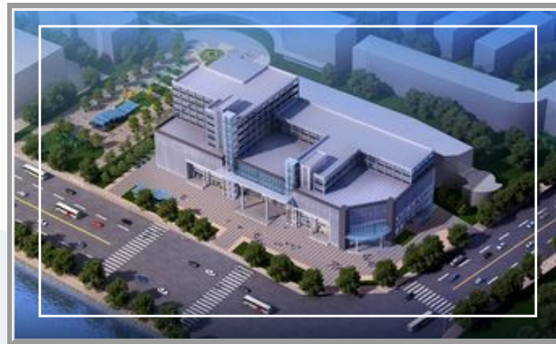
▷ 温岭市城东街道下岸渚村综合楼项目
