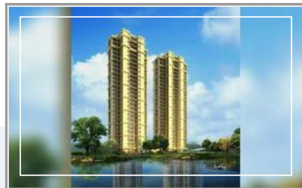
▷ 温岭市大溪镇云溪村股份经济合作社村民公寓式住宅工程
