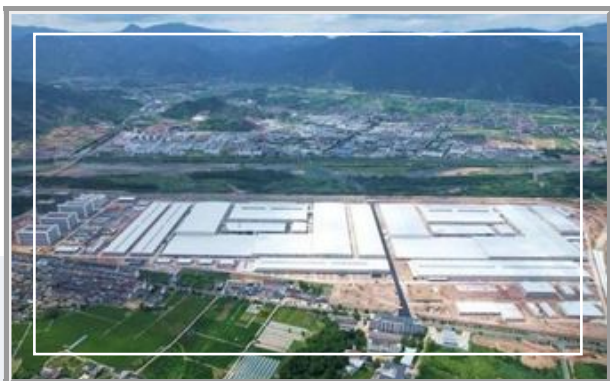
▷ 台州弗迪新源动力电池项（全过程咨询）项目
