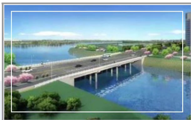
▷ 温岭市东部新区紫荆路1号桥桥梁工程
