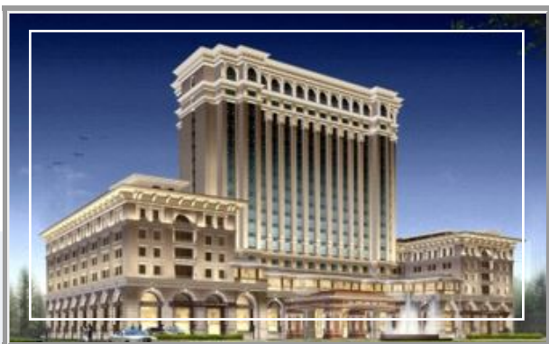
▷ 台州旗隆国际大饭店工程
