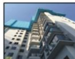
全混凝土外墙
