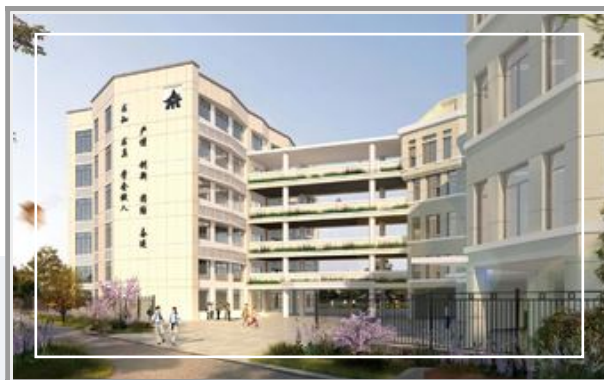
▷ 温岭市三中综合楼拆建工程
