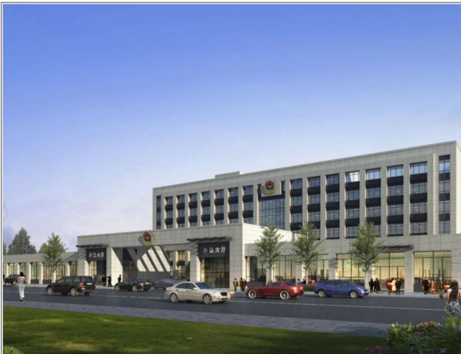
☆温岭公安局城南派出所、交警中队营房新建工程（2023年度浙江省建设工程“钱江杯”）
