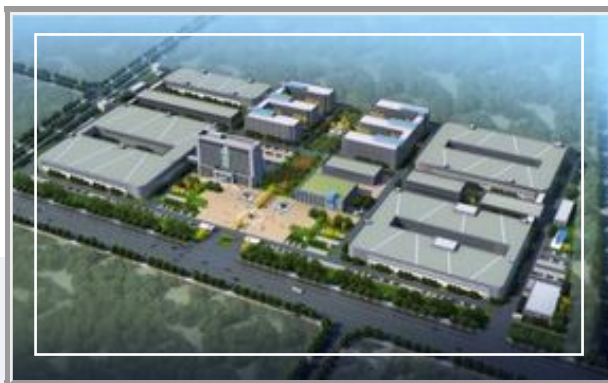
▷ 浙江水晶光电科技股份有限公司新厂区二期工程
