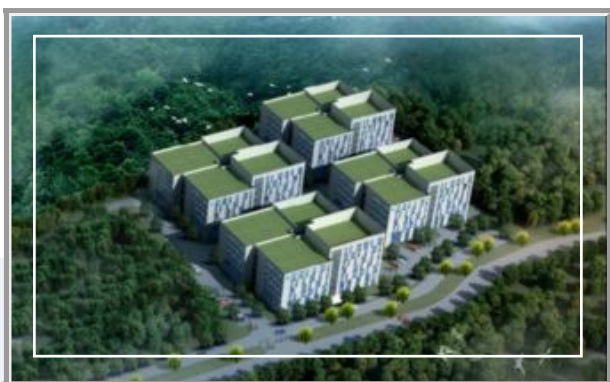
▷ 温岭市大溪镇沙岸产工业创业园项目
