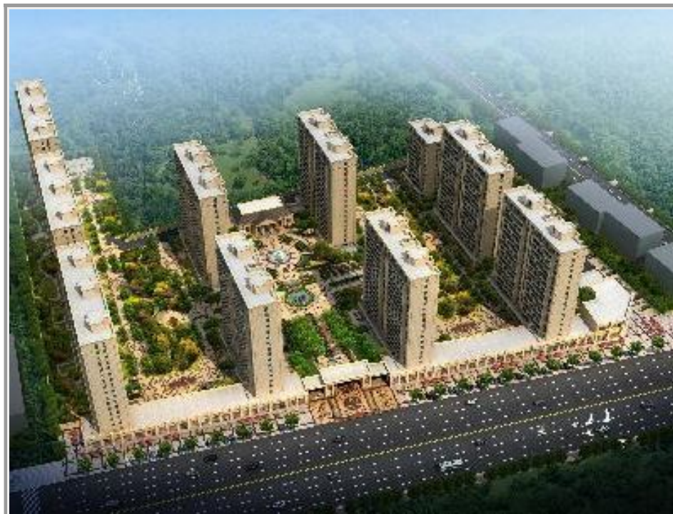
☆香溪望府工程 (2017年度温岭市标化工地)
