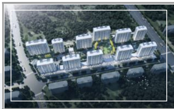
▷ 会展新城安置房六期二号地块项目
