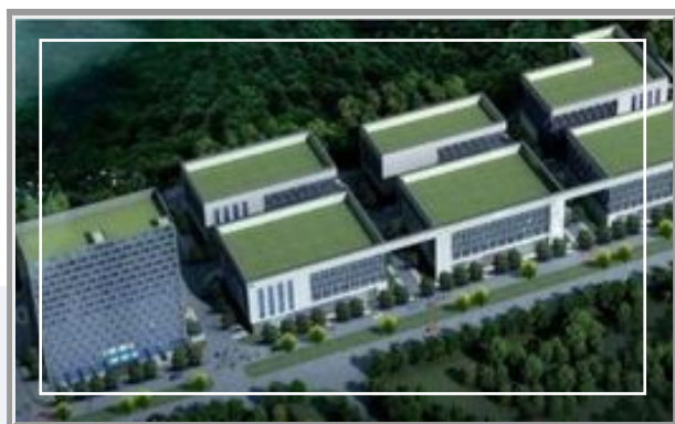
▷ 大溪镇沙岸村拆后利用工业地产一期EPC工程
