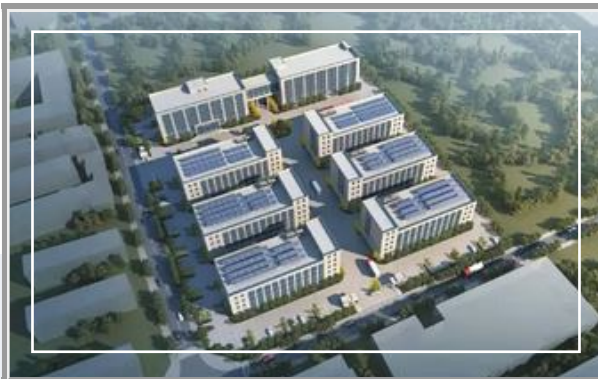
▷ 炬华科技智能电气智慧制造产业建设项目
