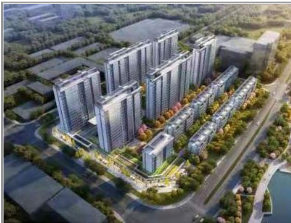
☆瑞安市东山西单元经济开发区起步区07-04地块商住 项目 (2022年度第二批温州市标化工地)
