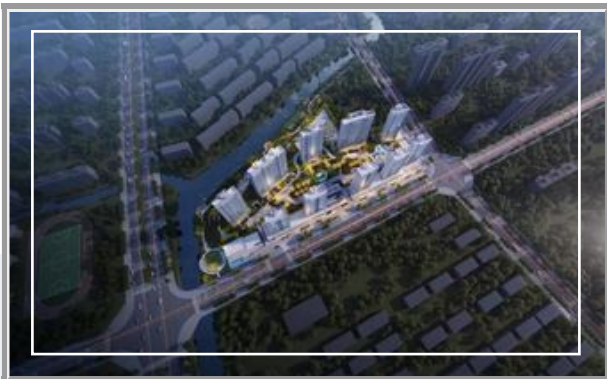
▷ 椒江区景元东路、太和路西侧地块（汉通东麟府）EPC工程
