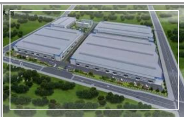
▷ 新成永创合金有限公司新建厂房项目
