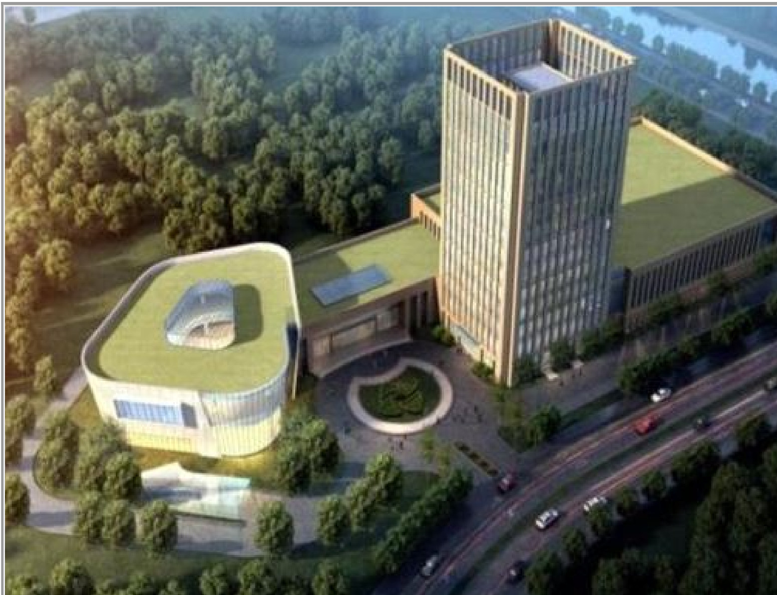
☆铁路新区泵业小镇技术中心、小镇客厅、泵业博物馆工程（2021年度浙江省建设工程“钱江杯”）
