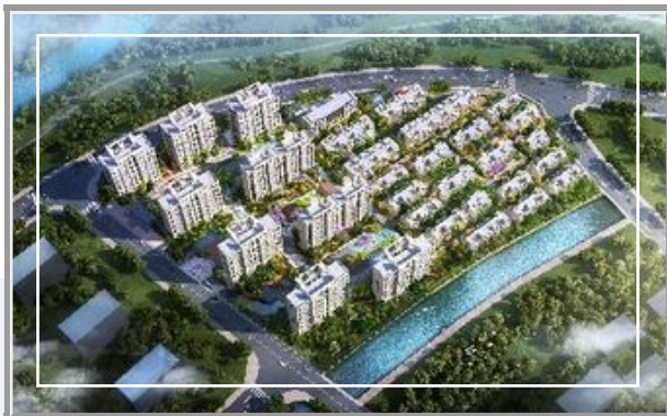
▷ 天台樾湖兰庭项目
