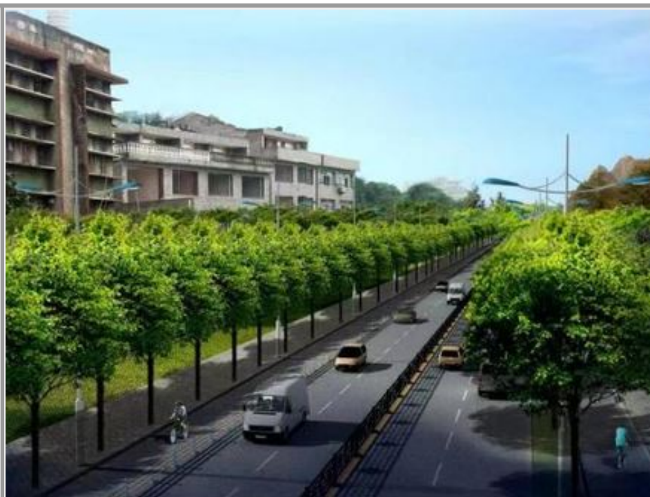
☆温岭市东辉南路改造工程 (2018、2023年度温岭市标化工地、2023年度温岭市建设工程“曙光杯”)
