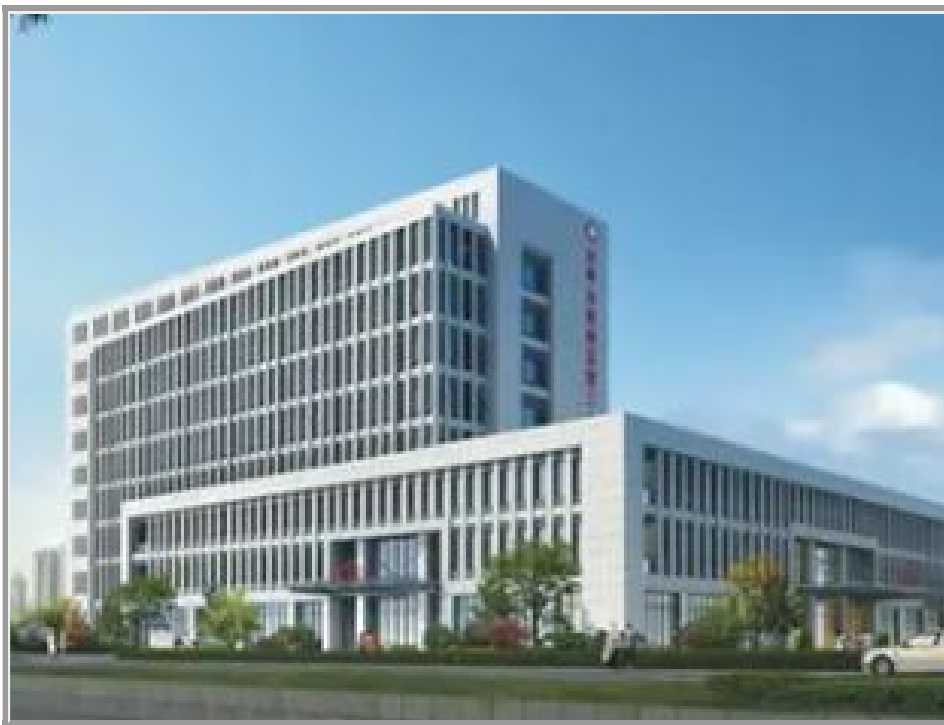
☆ 路桥区第三人民医院整体迁建工程 （2021年度台州市建设工程“括苍杯”、2020年度台州市路桥区建筑工程“月河杯”）
