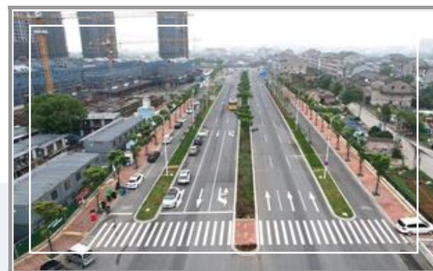
▷ 温岭市铁路新区牧潘路三期工程
